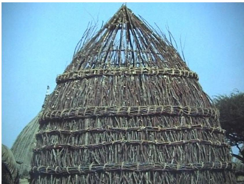
Bild 32: Schilfstrohdach, mit geflochtenen Seilen befestigt
