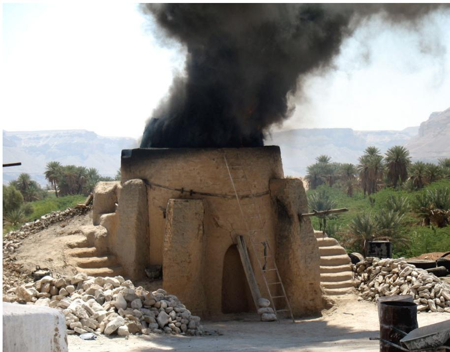
Bild 51: Kalkbrennofen im *Wādī Ḥaḍramawt*
