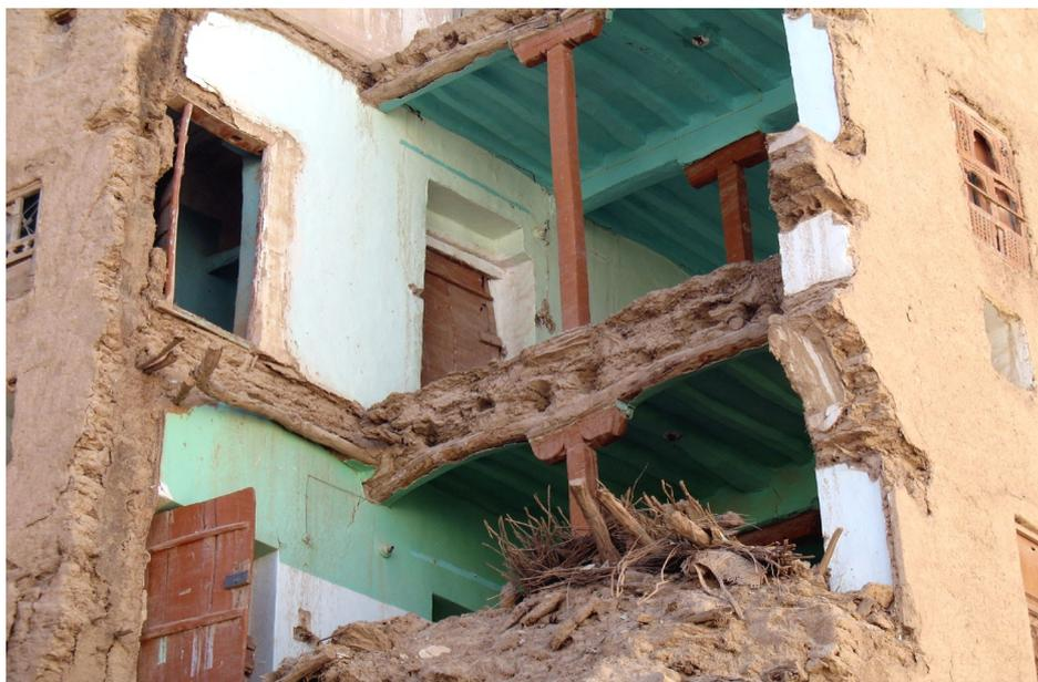
Bild 56: Deckenträger und Stützpfiler eines Hauses in *Šibām*
