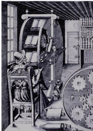
Abbildung 6.8: Abbildung des Buchrades aus Agostino Ramellis *Le diverse et artificiose machine* (1588, Public Domain).
