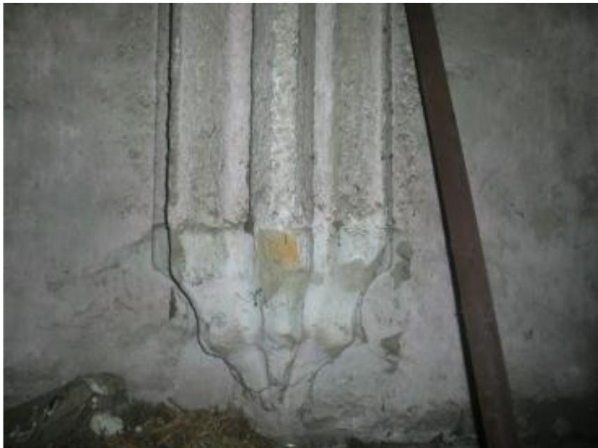
Abbildung 99 Gewölbeanlauf, Detail
