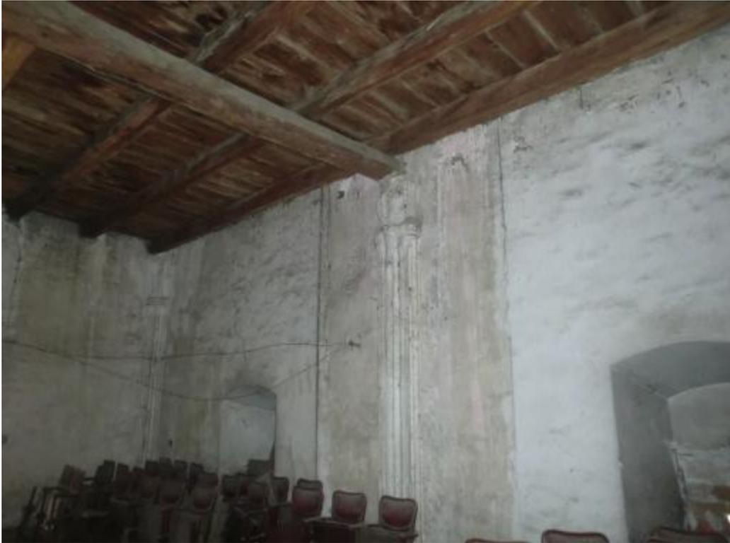
Abbildung 100 Gewölbeanlauf an der Westwand
