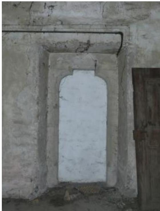
Abbildung 87 Westwand des Langhauses, zur Nonnenempore führendes Portal, heute vermauert
