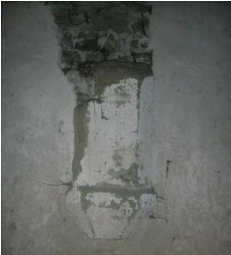
Abbildung 83 Rest des Gewölbeansatzes der ehemaligen steinernen Brüstung der Nonnenempore, südliche Langhauswand
