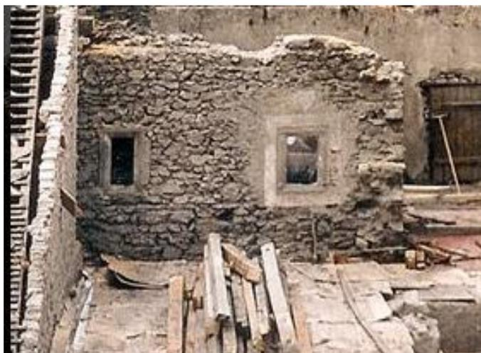
Abbildung 76 ehemalige gotische Fenster des Obergeschosses, die von der Klosterzelle in den davor liegenden Gang gerichtet waren
