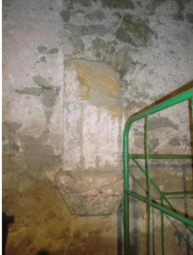
Abbildung 84 Rest des Gewölbeansatzes der ehemaligen steinernen Brüstung der Nonnenempore, nördliche Langhauswand
