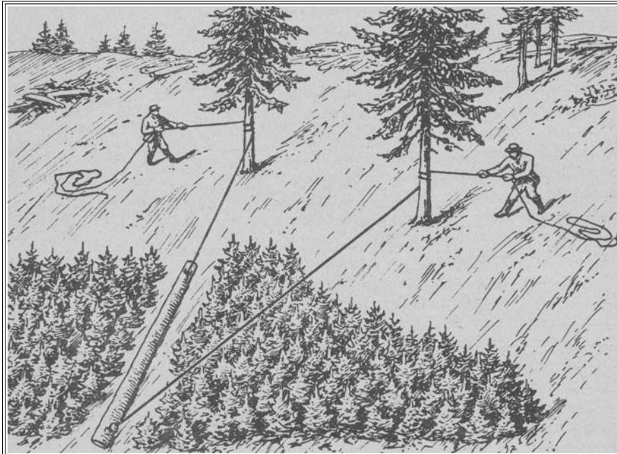
Abb. 21: Seilen mit Hilfe von zwei Seilen.
