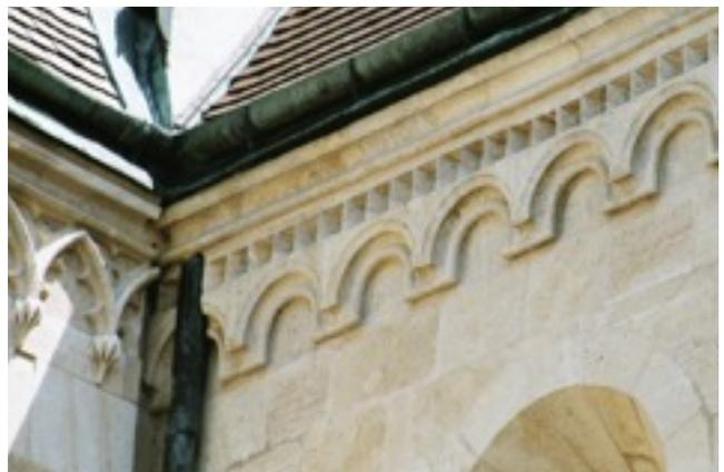
Abb. 36: Obergaden, Detail Rundbogenfries, Übergang zum Chor
