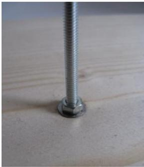
Abbildung 10: Bodenplatte verschraubt mit den Beilagenscheiben und Schraubenmuttern (eigenes Foto)
