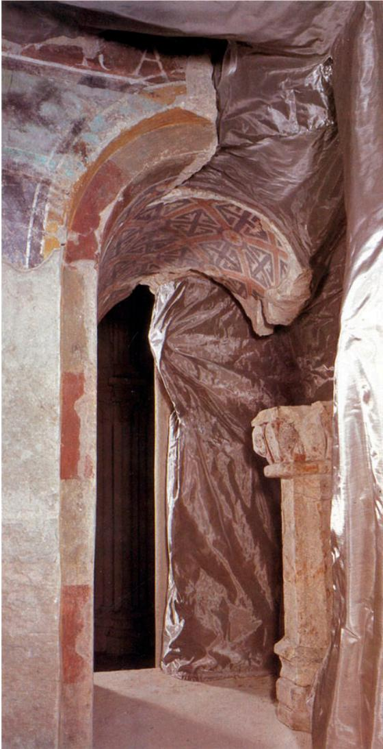
Abb. 41: Stift Klosterneuburg, Fenster zwischen Kreuzgang und Kapitelsaal, zwischen 1114 und 1136, Reste von Malerei, Säule aus Sandstein, Scheitelhöhe 135 cm, Säule 84,5 cm.
