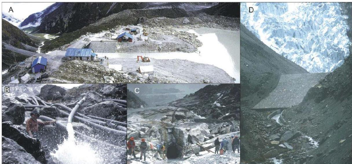
Abbildung 15: Gefahrenminimierung. A) Wasserabsenkung durch einen Abflusskanal (Tsho Rolpa, Nepal); B) Wasserabsenkung durch Siphons (Tsho Rolpa, Nepal); C) Wasserabsenkung durch einen Tunnel (Lake 513, Peru); D) Dammkonstruktion (Cuchillacocha, Peru) (Quelle: REYNOLDS (2003: 27))
