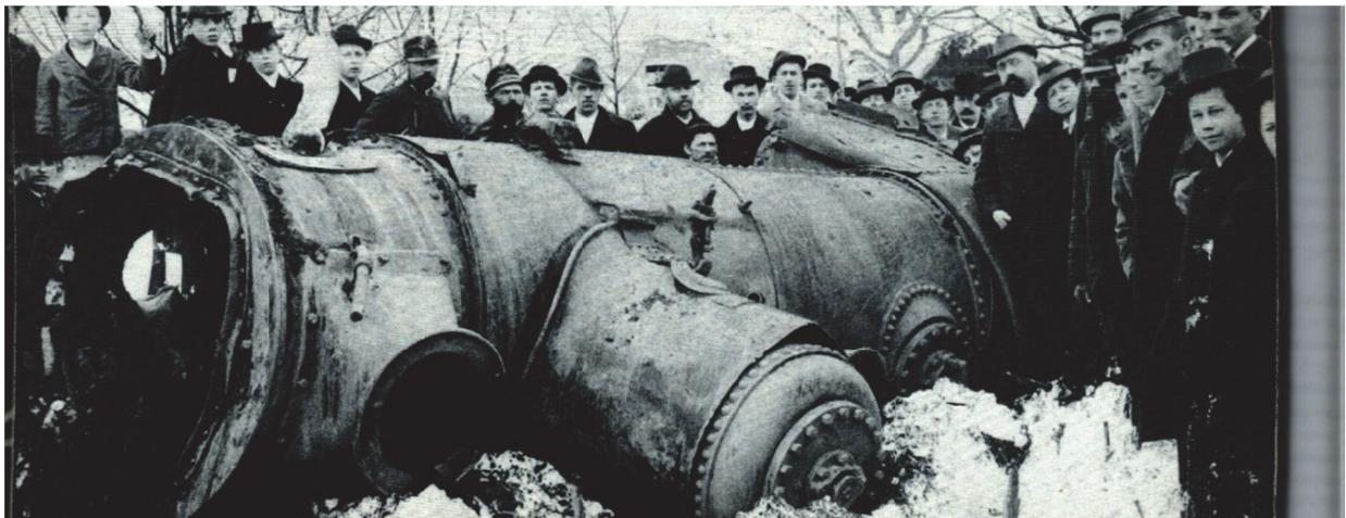
Bild 1: Explosion eines Lokomotivkessels in der Station Deutschlandsberg am 02. Februar 1902
