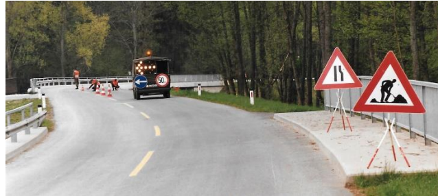
Abbildung 179: (Foto) Wallmeistertrupp bei (abgesicherten) Wartungsarbeiten an einer Stecksperrre (Foto: MilKdo K)
