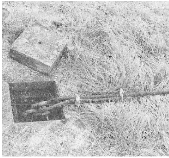
Abbildung 159: (Foto) Verankerung für/mit vorbereiteter Drahtseil-Sperre; aus Pi87, Seite 75 (dort: Abb. 75)
