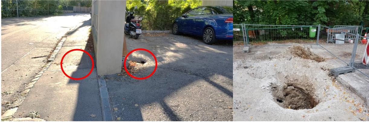
*Abb. 16: Erdfälle in Hinterbrühl (links: zwei kleine Löcher im Asphalt, rechts: zuerst verfüllter und wieder offengelegter Erdfall ©Irene Winkler*
