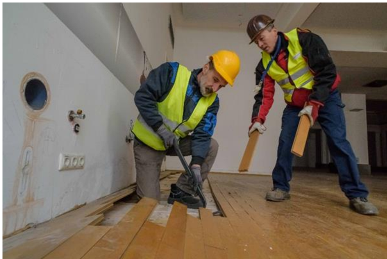
Abbildung 18: Herausarbeiten von Parkett am MedUni Campus Mariannengasse (Bauherr: BIG) (Aufnahme von © Harald A. Jahn – www.viennaslide.com )
