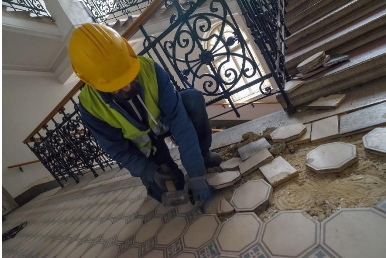
Abbildung 17: Herausarbeiten von Fliesen am MedUni Campus Mariannengasse (Bauherr: BIG) (Aufnahme von © Harald A. Jahn – www.viennaslide.com )
