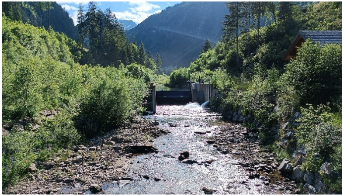
Abbildung 45: Wehranlage kurz vor dem Auslass des Schwarzeniseebachtals (nähe ECA-Nr. 3). Die Begradigung des Flusslaufes ist an beiden Seiten des Flusslaufes zu erkennen (Quelle: eigene Aufnahme 29.06.2023).
