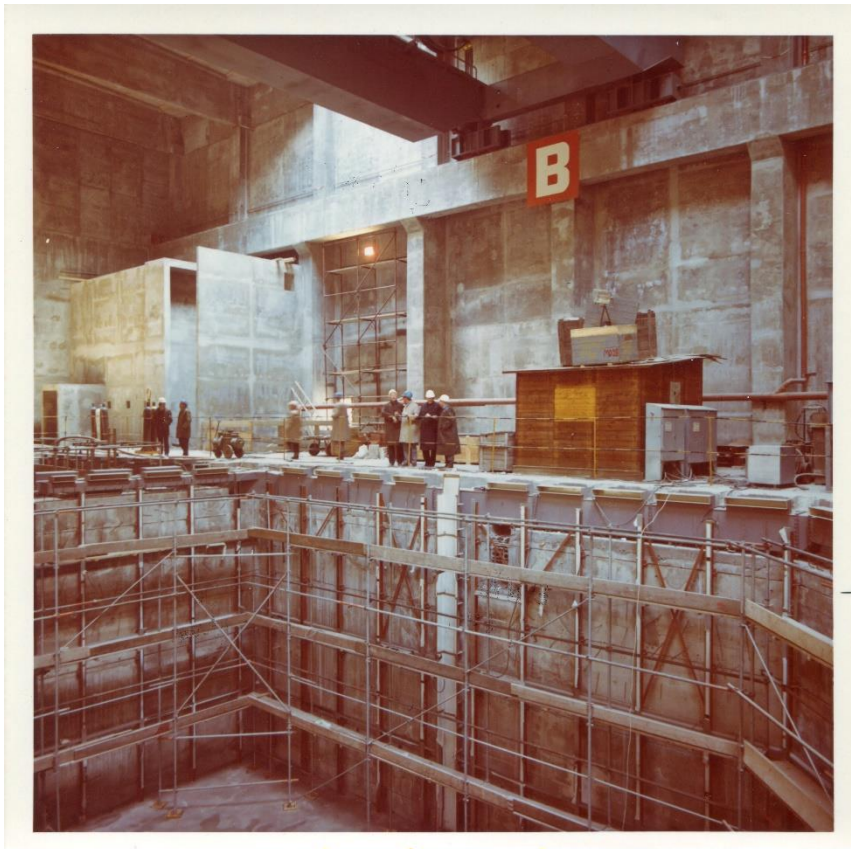
Abbildung 10: Reaktorhalle während dem Bau des Kernkraftwerks (EVN Archiv, Maria Enzersdorf).
