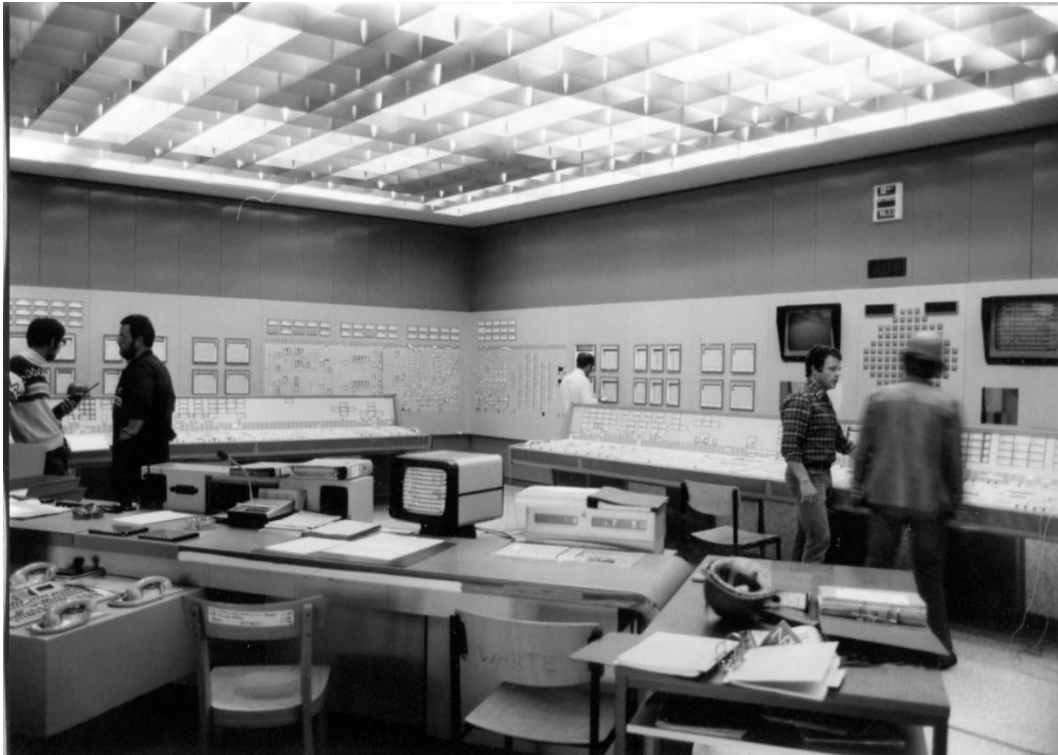
Abbildung 8: Die Schaltwarte des Kernkraftwerks Tullnerfeld (EVN Archiv, Maria Enzersdorf).
