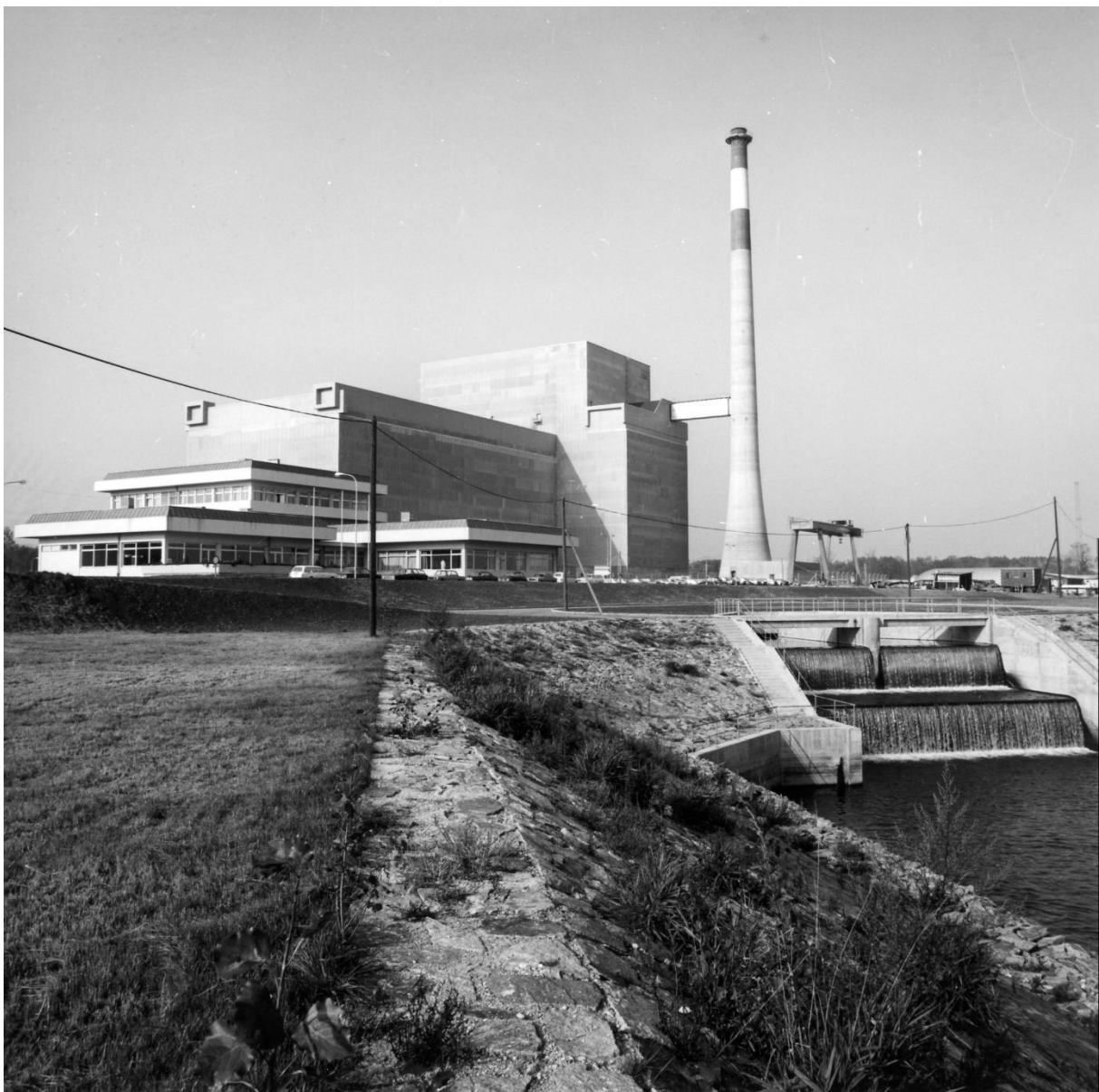
Abbildung 9: Das Kernkraftwerk Tullnerfeld mit dem Kühlwasserauslaufbauwerk im Vordergrund (EVN Archiv, Maria Enzersdorf).
