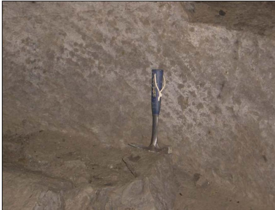
Abb. 3.4: Schrämmspuren in der Sandsteinbank durch den historischen Abbau.
