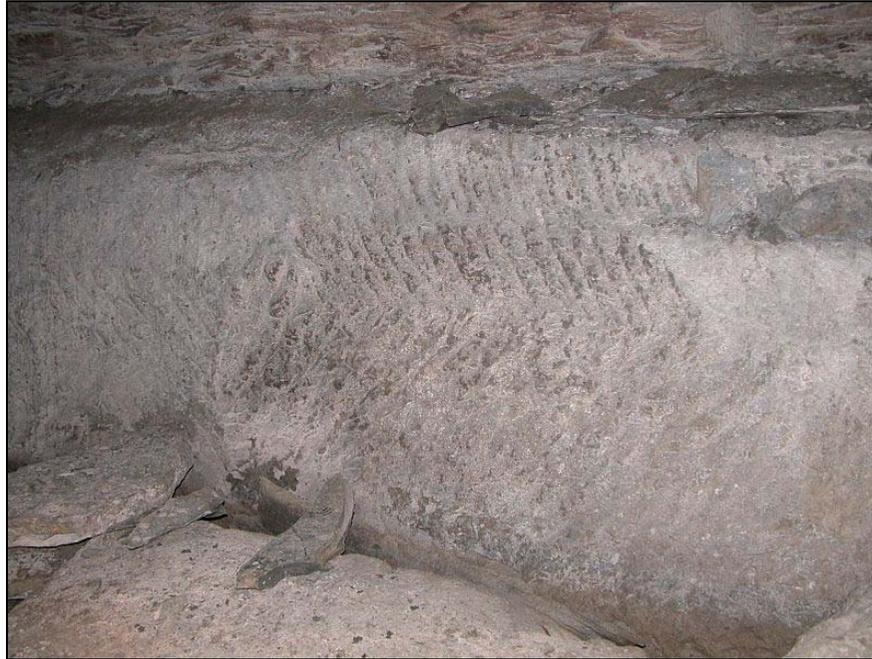
Abb. 5.2: 1 m mächtige Sandsteinbank, die Schrämmspuren des damaligen Abbaus sind noch zu erkennen
