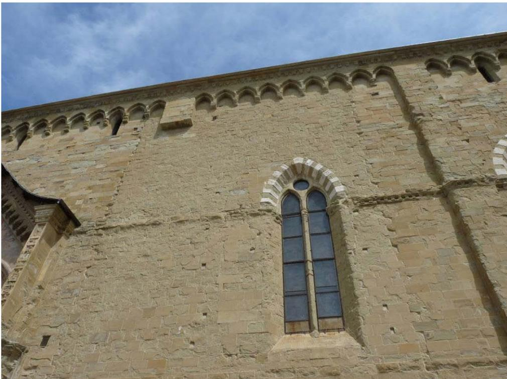
Abbildung 18: Dom von Arezzo, Südwand, erste und zweite Mauerfuge
