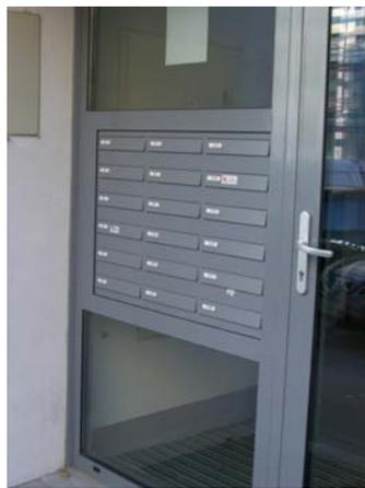
Abb. A-28: Vandalensichere Postkästen außerhalb des Hauszugangs
