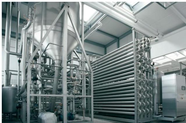
Abbildung 4.6 Direkte Erhitzungsanlage
