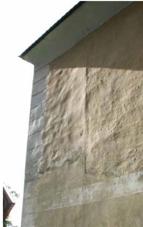
Abb. 18 Vermauerte Türöffnung an der Propstei, ursprünglicher Verbindungsgang zum nördlichen Treppentürmchen
