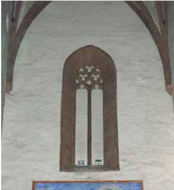
Abb. 13 Vermauertetes Maßwerkfenster an der Südwand des Querhauses
