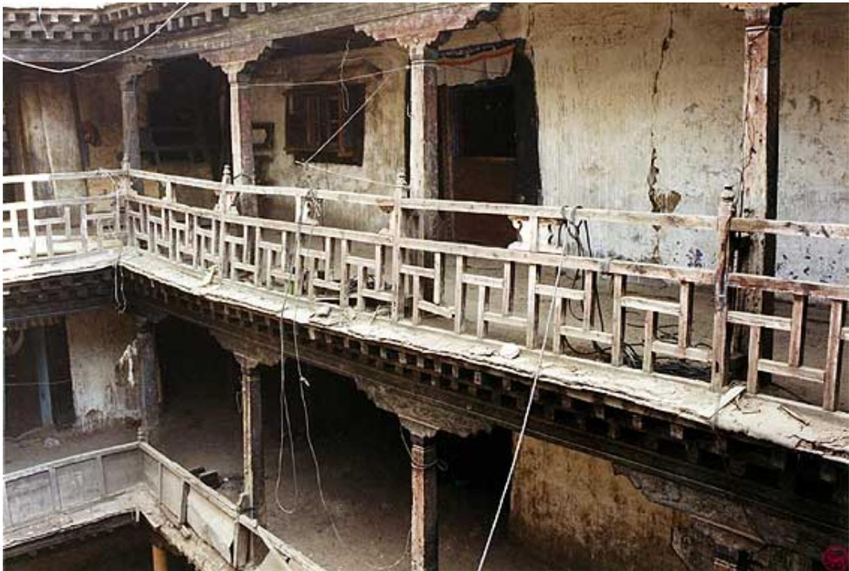
Abb. 92: Zustand des Arkadengangs im Innenhof vor den Instandsetzungsarbeiten des THF 1999/2000 ([http://www.tibetheritagefund.org/old\\_web/database/php/listresources.php?type=photo&id=4](http://www.tibetheritagefund.org/old_web/database/php/listresources.php?type=photo&id=4))
