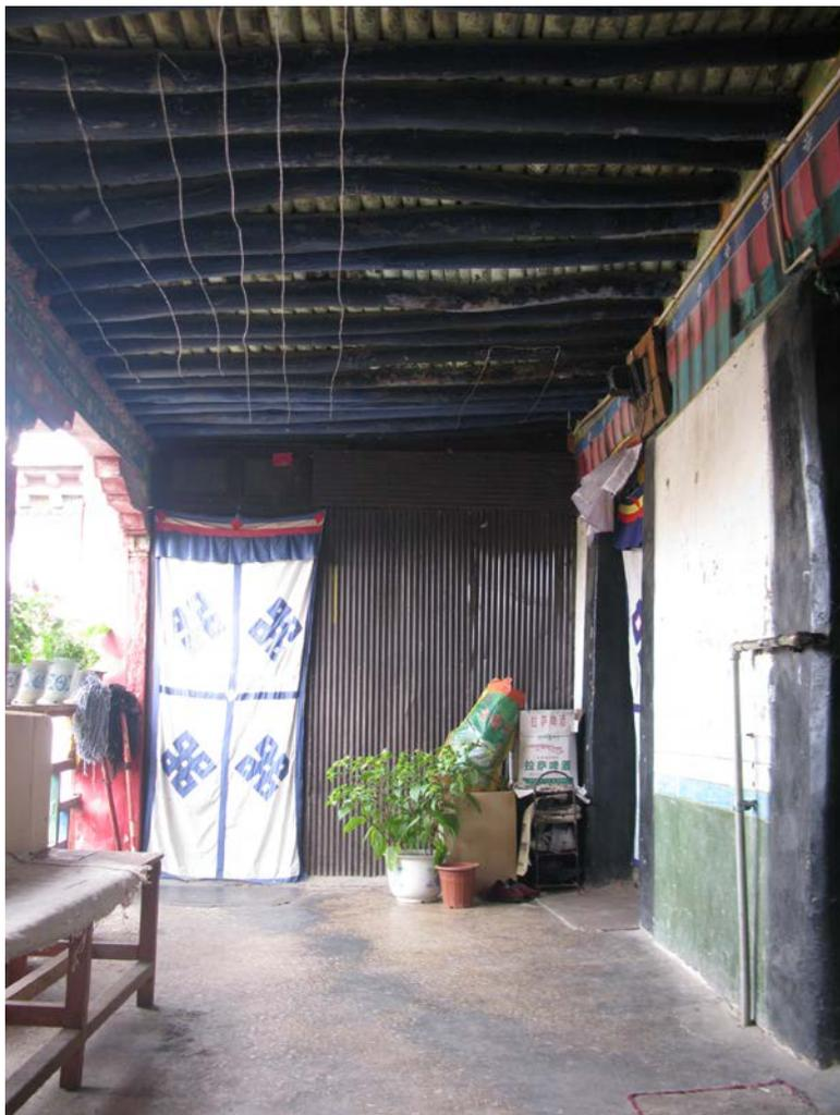
Abb. 25: 2. Stock, östlicher Arkadengang, mit Wellblech geschlossene nördlichste Achse (Schuhmeister 2010)
