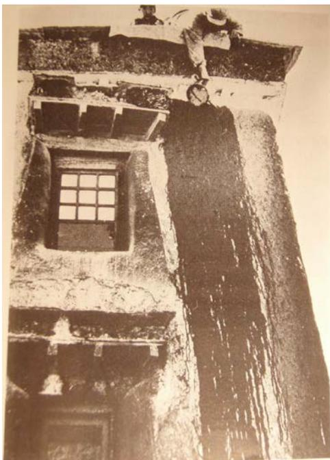
Abb. 128: Anstrich wird auf eine Fassade geschüttet (Meyer/Jest 1987)
