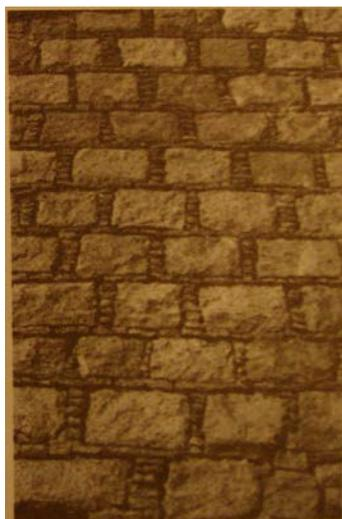
Abb. 105: Mauerwerk aus behauenen Steinen mit zwei verschiedenen Schichttypen, Detail der Bonshoe mansion, Beginn des 20. Jahrhunderts (Alexander/de Azevedo 1998)
