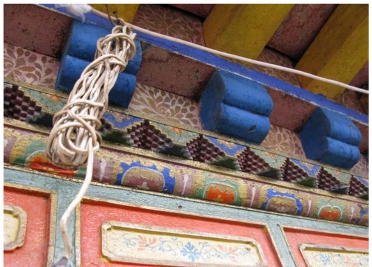
Abb. 57: Balkondetail, Zierleisten und Zahnschnitt (Schuhmeister 2010)
