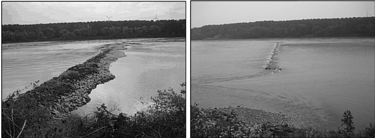
**Abbildungen 28 und 29:** Im linken Bild ragt die vor den Umbaumaßnahmen rechtwinkelig zum Ufer errichtete alte Buhne so weit aus dem Wasser, dass sie nicht mehr überströmt wird; nach der Umgestaltung wird die neue, in Strömungsrichtung geneigte niedrigere Buhne auch durch einen sogenannten Hinterrinner<sup>123</sup> in Ufernähe ergänzt (Quelle: VIA DONAU{10}, web).
