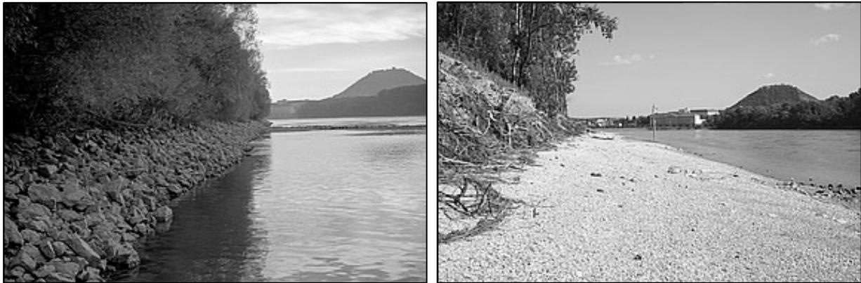
**Abbildungen 26 und 27:** Beispielhafte Gegenüberstellung von einem mit Blockwurf befestigten Uferstück links und dem gleichen Abschnitt rechts; nach dem Uferrückbau entwickelte sich rasch ein natürliches Flussufer (Quelle: VIA DONAU{10}, web).
