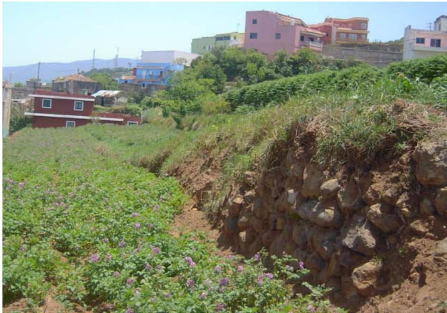
**Abb.22: Durch Bodenerosion geschädigte Mauer aus Steinen über einem Kartoffelfeld**
