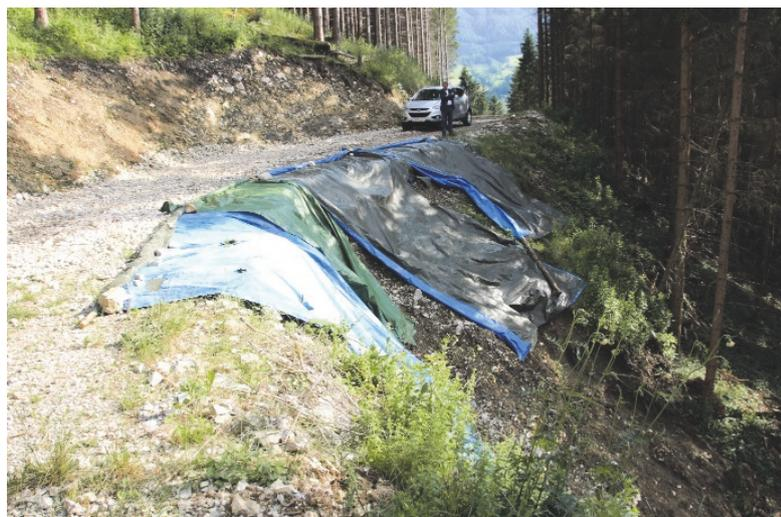
Abbildung 24: Abdeckung des Anrissbereichs mit einer Plane am Beispiel der Rutschung-ID 34 in Hollenstein an der Ybbs (Foto: Gokesch 2014)
