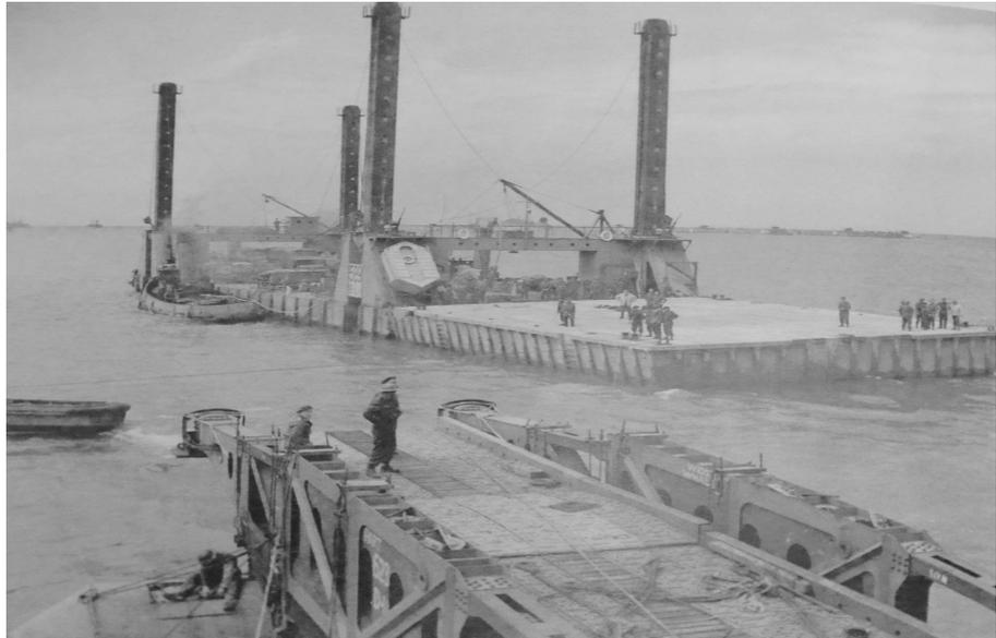
Abbildung 14: Pierhead mit angeschlossenem Cargo Pierhead.
