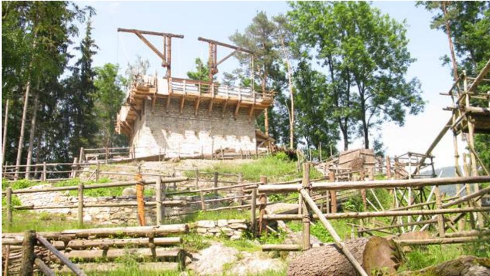
*Abbildung 7: Der Wohnturm mit Baugerüst und Kränen. Im Vordergrund rechts: Die Wasserleitung führt über die Stützen in gleichmäßigem Gefälle zu Tal.*
