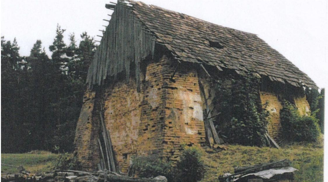
Abb. 57: Ziegelei Kloiber Fratres, Ziegelofen III (Identifikationsnr. 12) Südansicht, links Frontseite, in schlechtem Zustand. Der Akazienbaum wurde bereits entfernt, dafür begann das Dach aufzureißen. Vor 2003.
