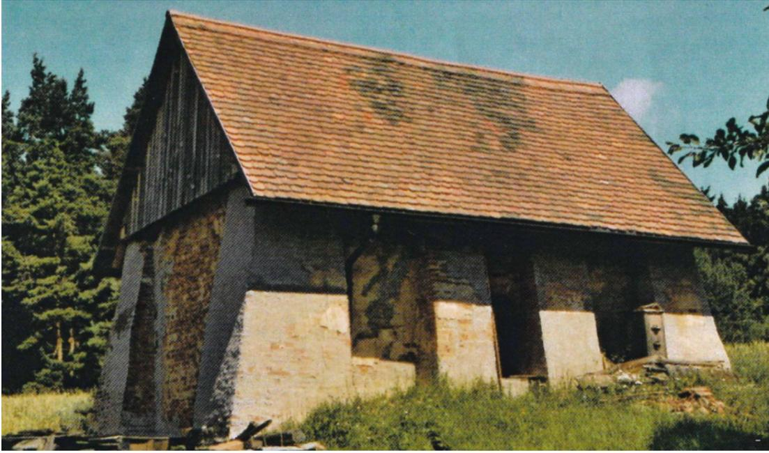
Abb. 36: Ziegelei Kloiber Fratres, Ziegelofen III (Identifikationsnr. 12) Südansicht, links Frontseite. Im Vergleich zu Abb. 35 fehlt die Lüftungsvorrichtung/Laterne. Nach Sicherungs- und Restaurierungsarbeiten im Jahr 2003.
