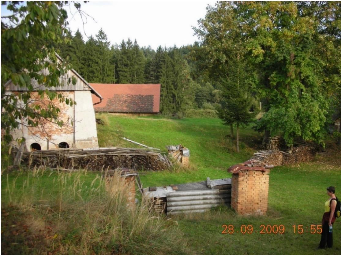
Abb. 52: Ziegelei Kloiber Fratres, Ziegelofen III (Identifikationsnr. 12) Westansicht, Frontseite mit erkennbaren Einfuhr-/Feuerungsöffnungen, vor dem Ofen viele Festmeter Scheitholz. Im Vordergrund drei Säulen des 1960 nach Blitzschlag abgebrannten ‚großen Schlagschuppens‘ (Identifikationsnr. 16), im Hintergrund der ‚Mauerziegelschuppen‘ (Identifikationsnr. 11) nach Sanierung. Aufnahme aus dem Jahr 2009.
