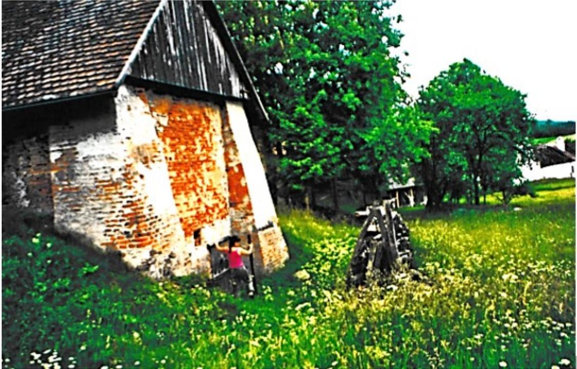
Abb. 26: Ziegelei Kloiber Fratres, Ziegelofen III (Identifikationsnr. 12). Die hohen Temperaturen, die im Ofen herrschten, erforderten mächtige Mauern und eine massive Bauweise. Nordwestansicht mit Person zum Größenvergleich. Aufnahme aus dem Jahr 2006.
