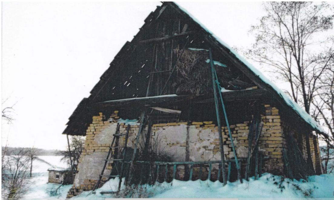
Abb. 56.2: Ziegelei Kloiber Fratres, Ziegelofen III (Identifikationsnr. 12) Ostansicht, Rückseite, in schlechtem Zustand. Akazienbaum vorne rechts im Bild sprengt den Ofen auf. Vor 2003.
