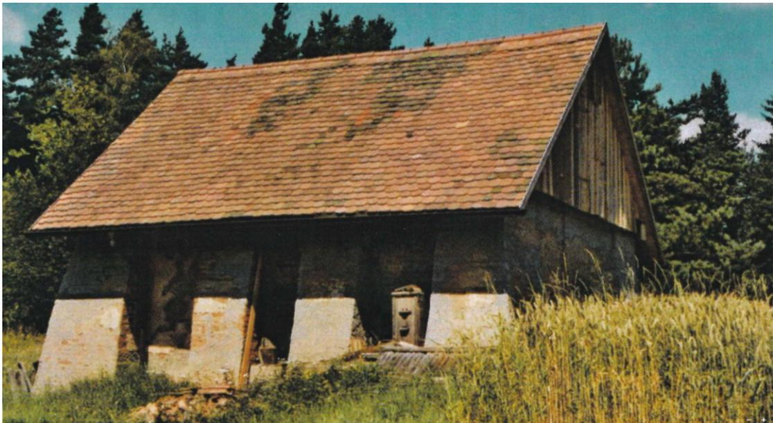
Abb. 58: Ziegelei Kloiber Fratres, Ziegelofen III (Identifikationsnr. 12) Südansicht, rechts Rückseite, nach Sicherungs- und Restaurierungsarbeiten im Jahr 2003. Auffällig die veränderte Eindeckung: statt Einfachdeckung mit Spließen nun Doppeldeckung zwecks besserem Schutz vor Witterung.
