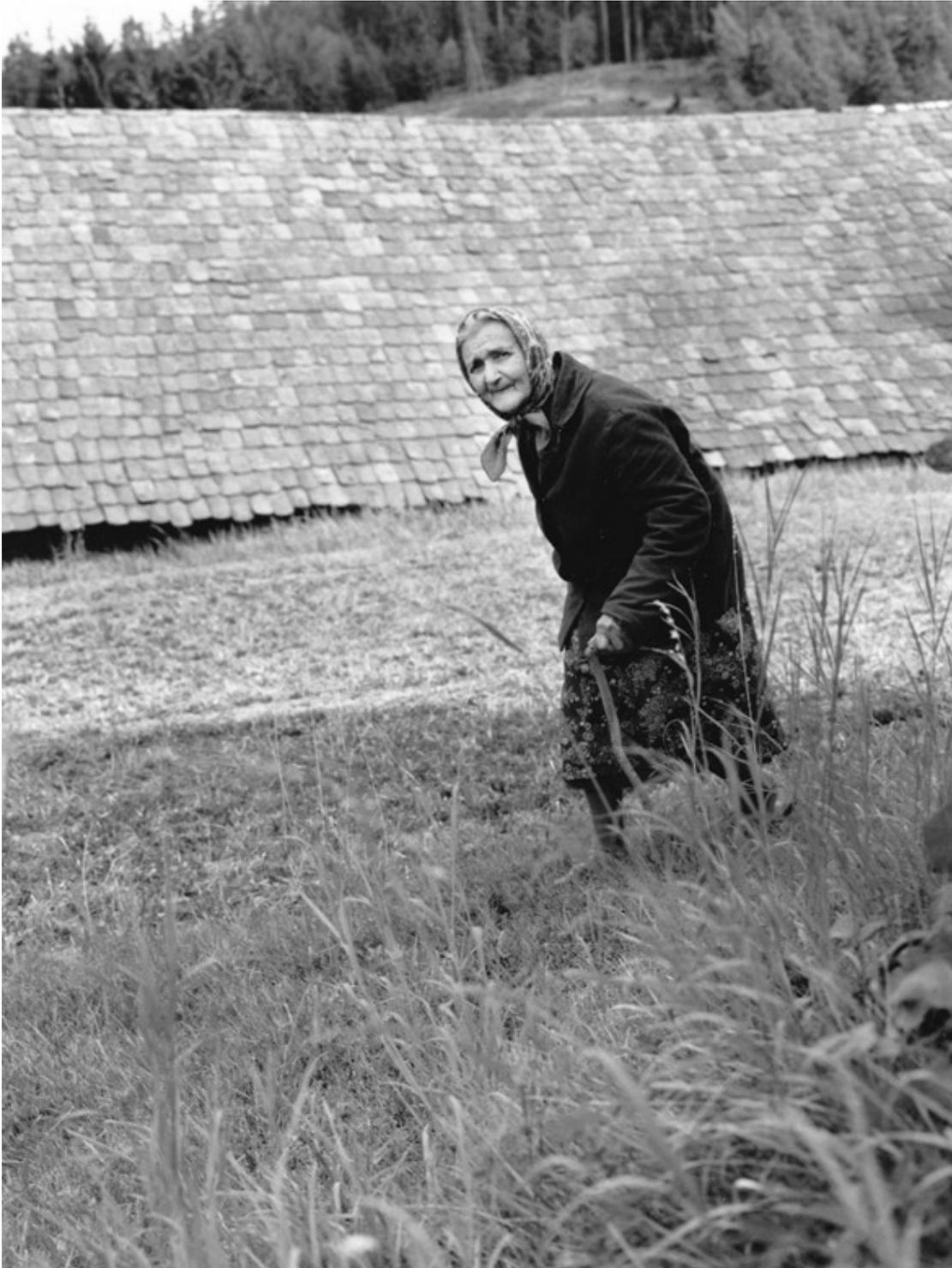
Abb. 61: Hermine Kloiber vor ‚Mauerziegelschuppen‘ (Identifikationsnr. 11). Die Einfachdeckung mit Spließen ist hier gut zu erkennen. Aufnahme ungefähr um 1997.
